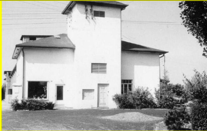
Grafik 16 Von diesem Haupt-Trafo wurden die Kabel bis zu den Transformatoren in A, C und D gelegt. B hatte kein Trafohäuschen
